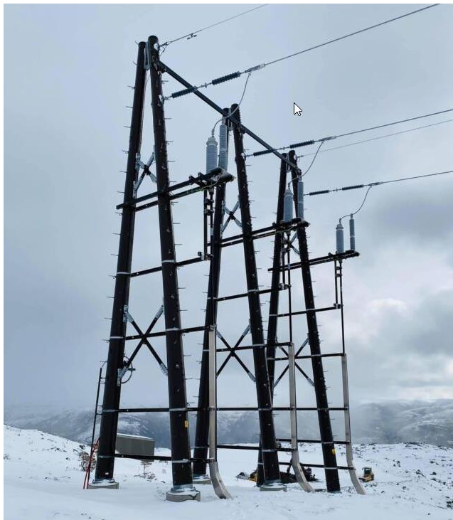
3A-mast på fundamenter Sørmarkfjellet
